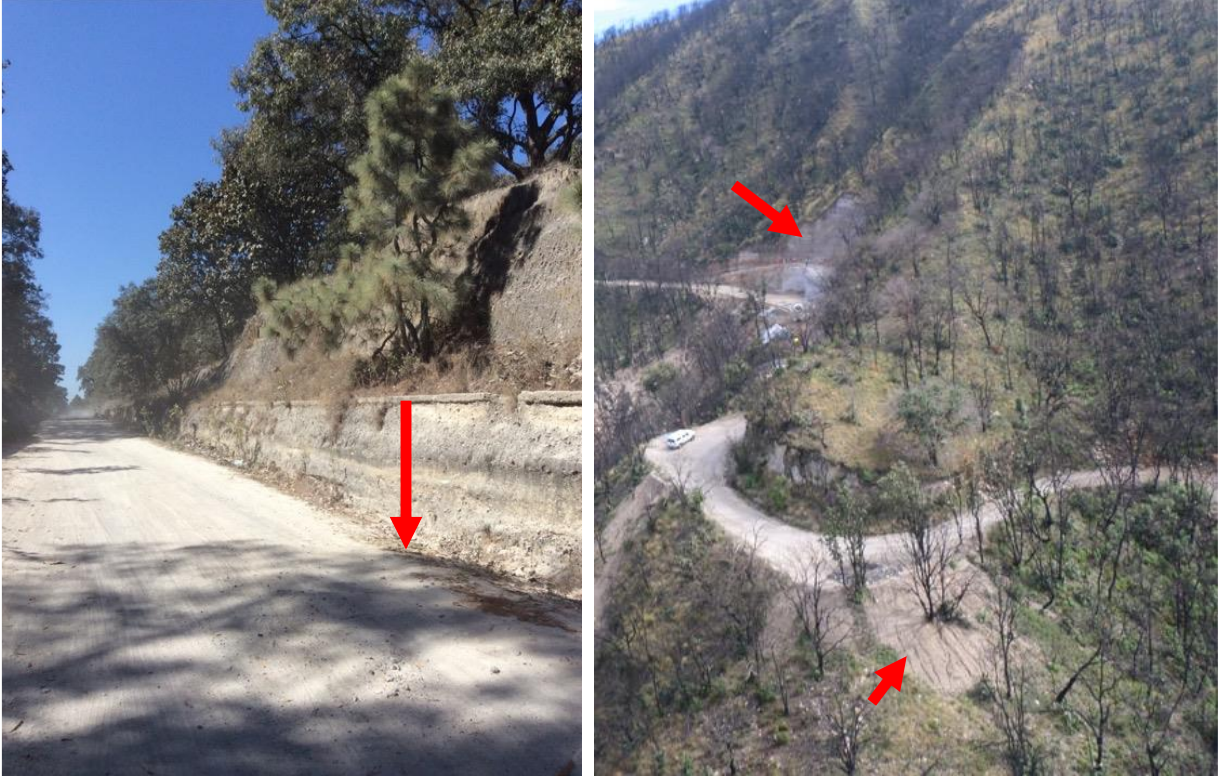
Figura 62. Los caminos y brechas son el principal factor antropogénico de pérdida de suelo e inestabilidad de laderas en el Bosque La Primavera. En la fotografía de la izquierda la flecha indica la pérdida de suelo entre el nivel original de la cuneta de mampostería y la superficie actual del camino (una diferencia de aproximadamente 1.5 m). A la derecha puede apreciarse la combinación de los efectos de una brecha y de un incendio severo en la erosión de suelos y la inestabilidad de laderas.
